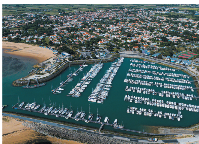
Saint-Denis d'Oléron - Travaux de PATA au port
