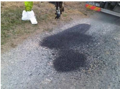
3. **Bouchage du trou ou de la zone déformée, fermeture et jointage** : La lance projette un enrobé tiède à l'émulsion de bitume qui :
