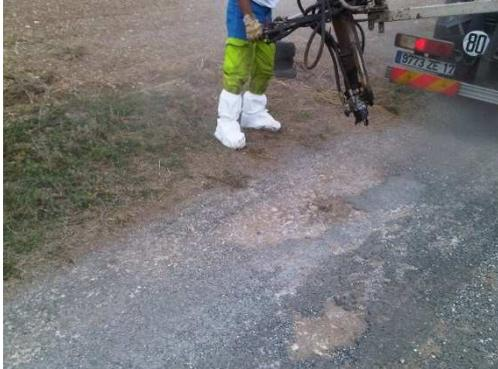
1. **Nettoyage du support** : La lance souffle de l'air comprimé ou de l'eau, afin de :
