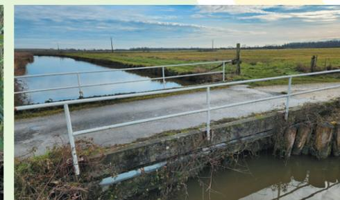
**Pont mixte dalle béton / voûte maçonnée**
